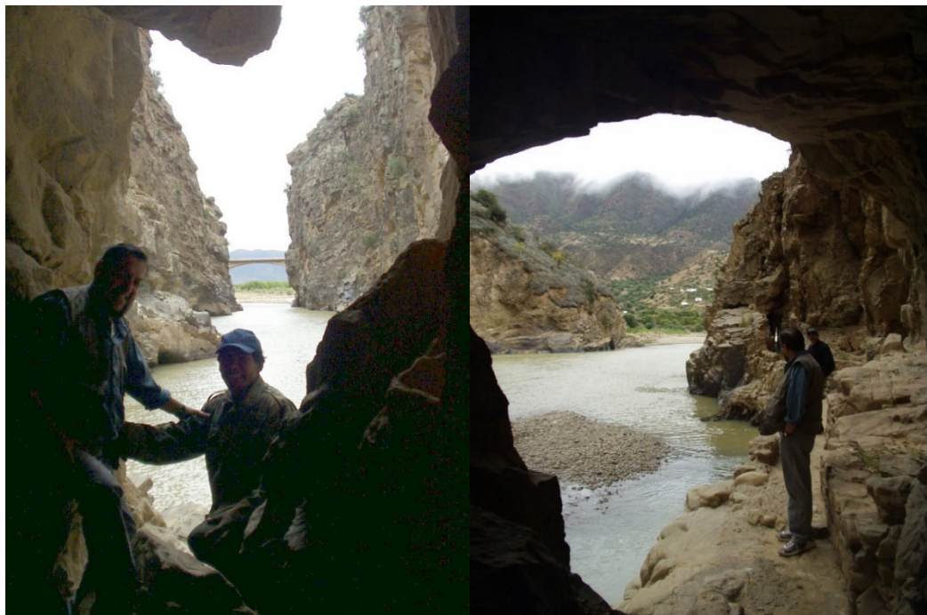
Vista de la entrada del túnel. Se puede ver el puente de la carretera.
