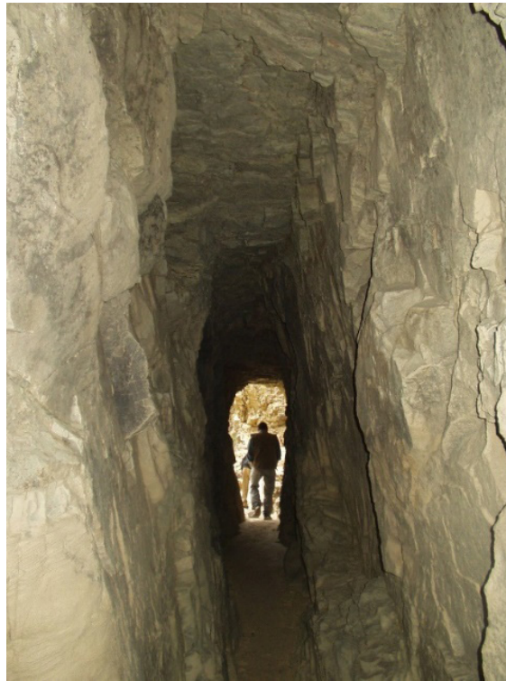
Túnel construido dentro de la roca para regar las tierras.
